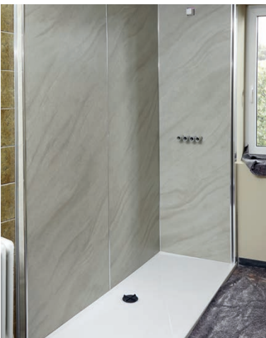
6 | Armaturen + Duschkabine montieren
